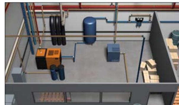
Обычный компрессор с внешним фильтрующим оборудованием и высоким уровнем шума приходится размещать в удалении от производственных площадей. Такое отсутствие интеграции может существенно увеличить затраты на монтаж.
